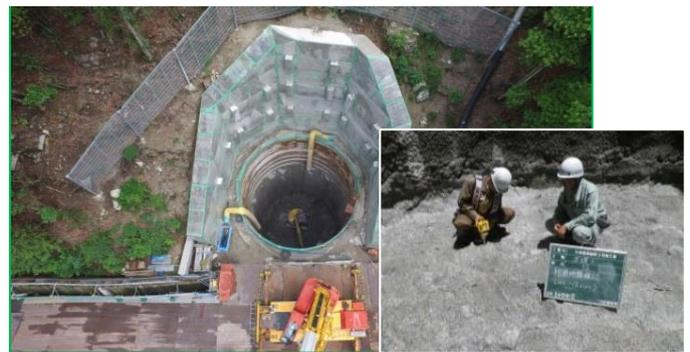
杭の下の強さを計測しています
