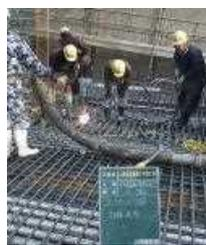
⑤ 振動機を使って均一に締固めます。
