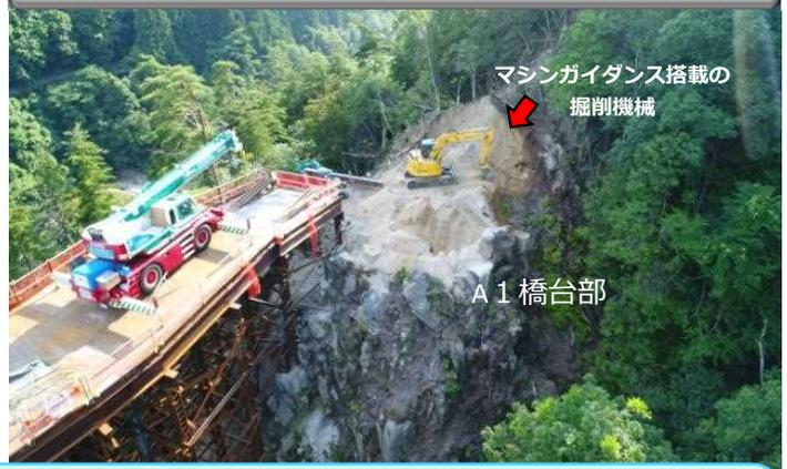
【ICT技術-マシンガイダンスとは】前回紹介した3Dスキャナーによる画像データから掘削位置が特定されており、そのデータを掘削機械に記憶させます。GPSにて掘削機械の位置を特定することにより、機械に搭載しているモニターからバケットに沿って掘削計画線が確認できるようになります。さらに、バケットは掘削計画線を超える掘削を行わないよう制御されており、自動的に計画どおりの掘削が行えます。従来の掘削方法のように、掘削のための位置出し等の準備に人手が掛からなくなりました。
