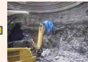
基礎部分は、岩盤層に達するため油圧ブレイカーや発破作業にて掘り進めます。
