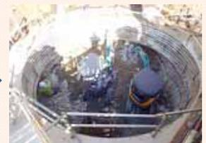
道路を支える、直径6mの井筒式の基礎を掘削します。
