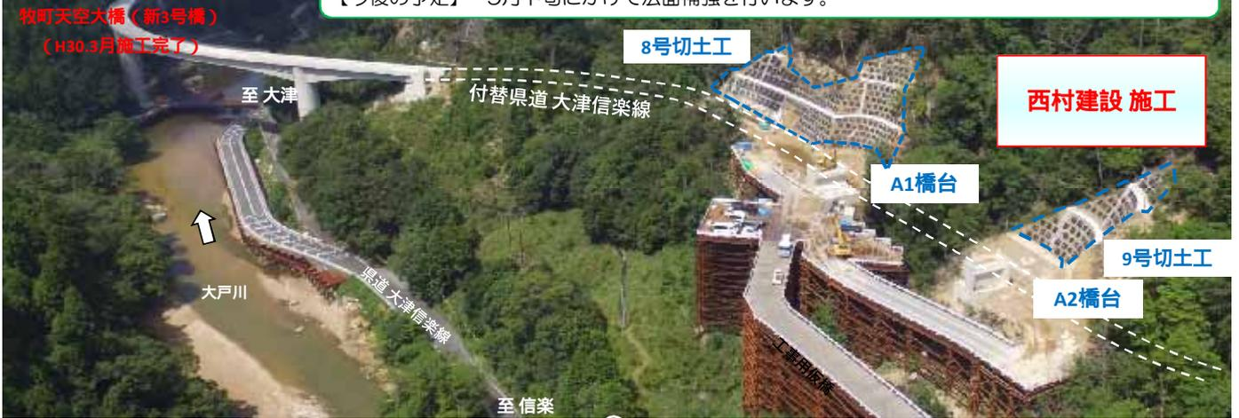
工事の進捗状況：A1橋台、A2橋台ともに作業足場を撤去し埋戻しを行いました。
