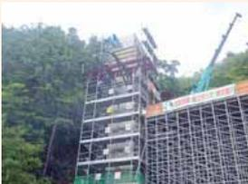
完成した基礎の上に橋脚を作るため、足場・鉄筋・型枠を組み立てます。
