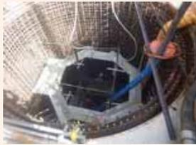
鉄筋を組立、コンクリートを打設し、基礎を仕上げます。
