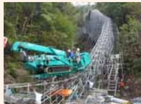
大型モノレールにて作業機械を施工箇所まで荷揚げします。
