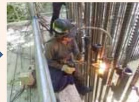
鉄筋を、繋ぎ合わせ(圧接作業)ます。
