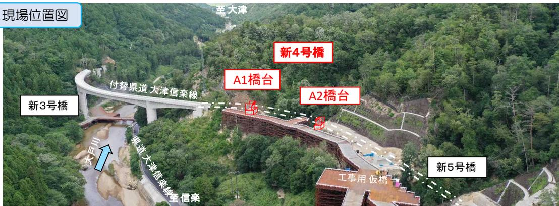
【工事の進捗】 A1橋台の床掘が完了しました。 【今後の予定】 9月下旬より深礎工を進めていきます。
