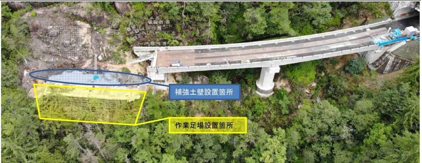
「大津信楽線桐生地区道路改良その他工事」は、据付コンクリート及び補強土壁工(5段目)を施工中です。
