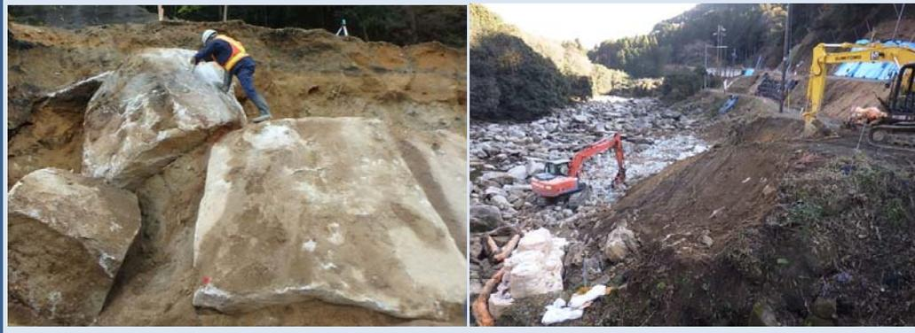
現場は転石が多く、掘削が難航しましたが、2号補強土壁部は地盤改良に着手します。師走に入り、慌ただしくなりますが、安全第一に進めてまいります。
