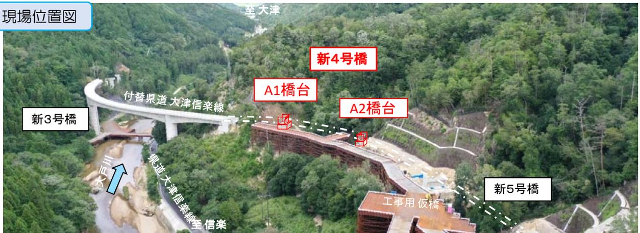
【工事の進捗】 A1橋台の躯体工を施工しています。【今後の予定】 A2橋台の土留・仮締切と床掘を施工しています。
