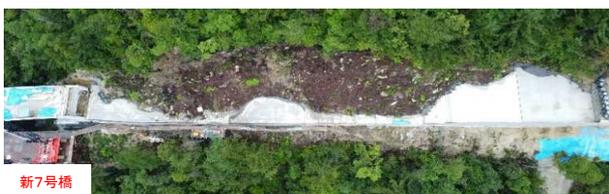
※軽量盛土28段の内9段施工完了
