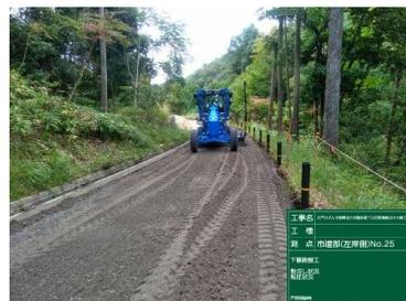
下層路盤が完了し、上層路盤、アスファルト舗装を行います。舗装完了後、ガードレールのビームを設置します。
