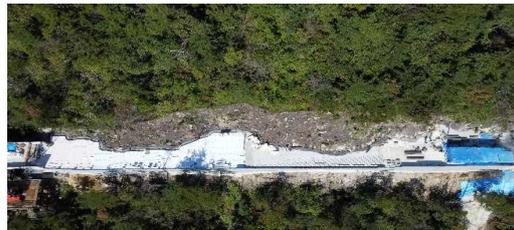
※軽量盛土28段の内15段施工完了
