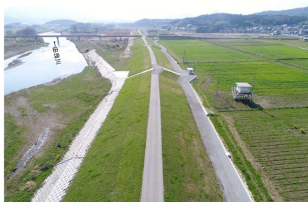
連続堤(福知山市川北地区)
