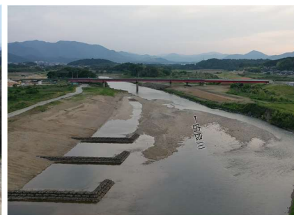
河道掘削(福知山市川北地区)
