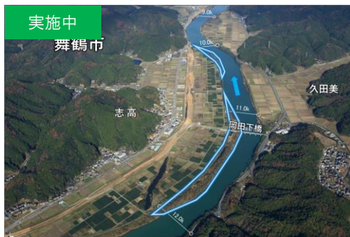
河道掘削(舞鶴市志高地区)
