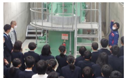
弘法川排水機場の施設案内の様子
