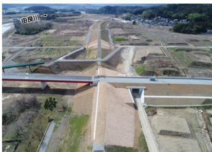
連続堤(福知山市川北地区)
