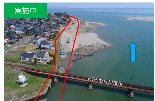
堤防整備(宮津市由良地区)
