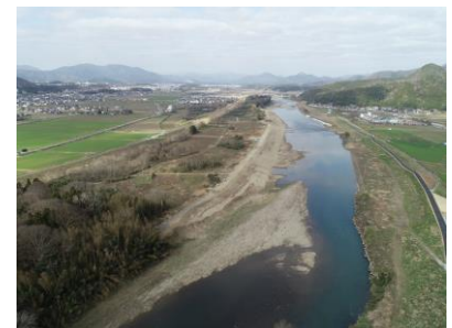
河道掘削(福知山市前田地区)
