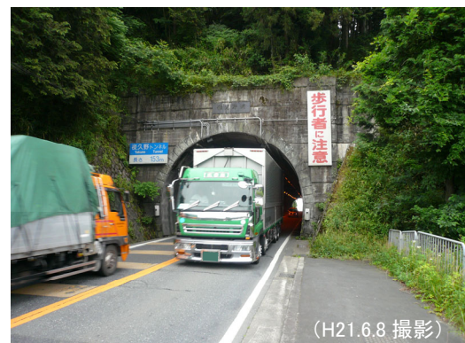
夜久野トンネル
