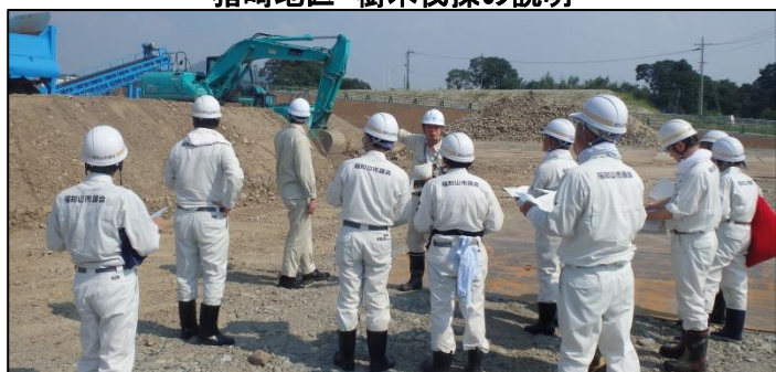
川北地区 築堤工事の説明
