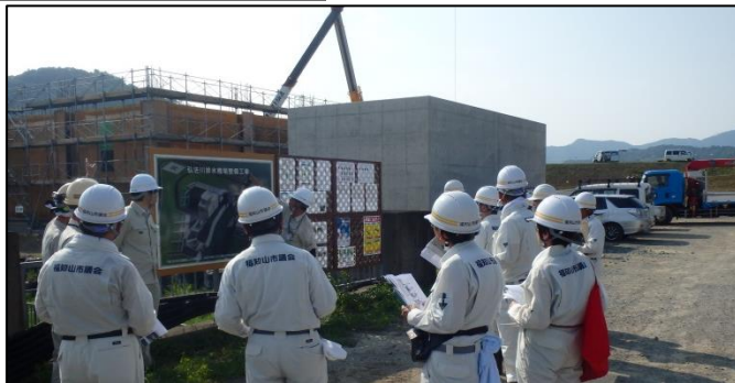
弘法川排水機場 新設工事の説明
