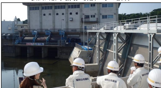
法川排水機場 増強工事の説明
