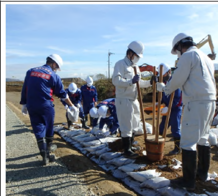
土のう積み様子
