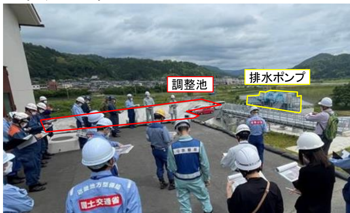
内水対策事業実施箇所（福知山市大江町新町地内）
