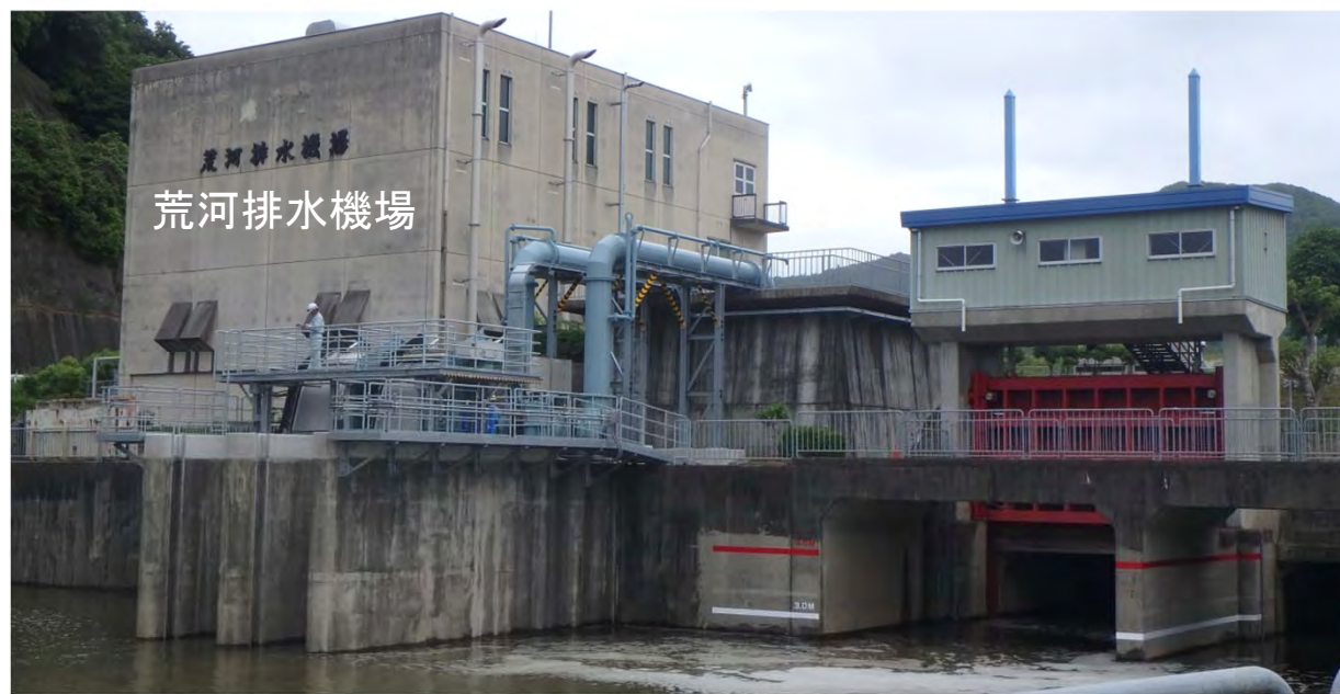
荒河排水機場
