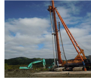
工事施工状況（下東地区）
