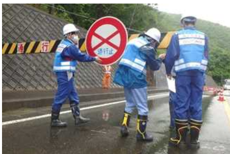
遮断機操作訓練
