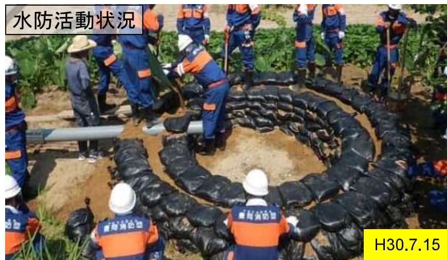
釜段工完了
