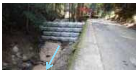
ブロック堰堤<7/17設置>
