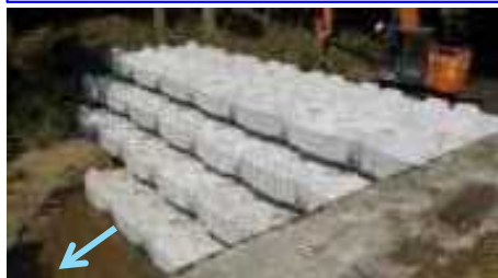
大型土のう設置<7/14設置>
