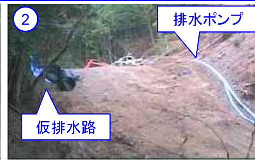
水位低下対策状況<8/10時点> (webカメラより)
