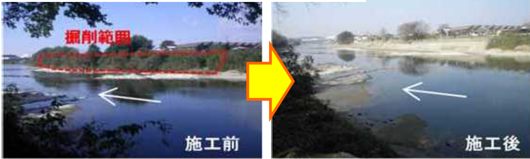
●掘削事業 施工状況(加古川33.8k付近)
