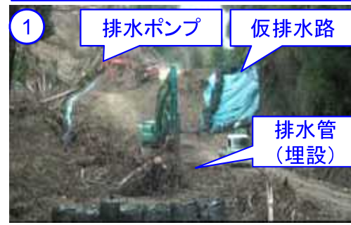
水位低下対策状況<8/10時点> (webカメラより)
