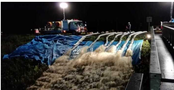
志高中央樋門 10月1日1時頃
