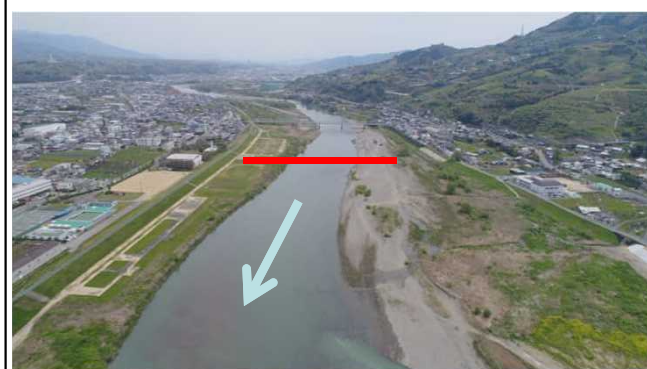
— 三谷水位観測所 断面位置
