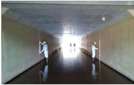
図 5.4.1 河川管理施設（樋門）の点検
