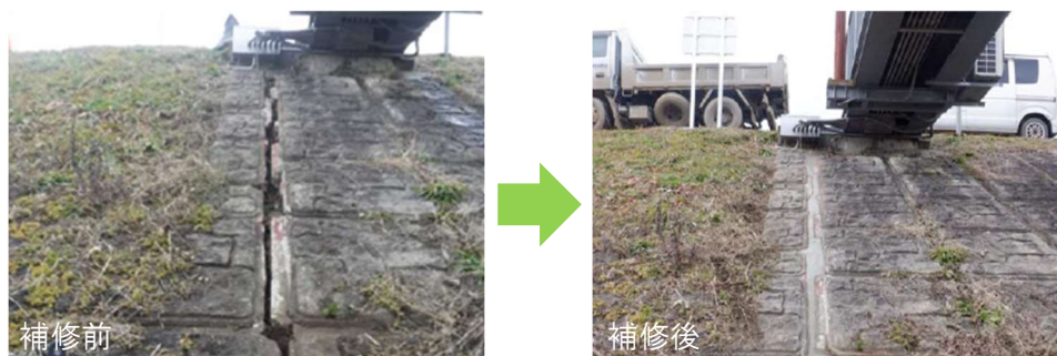
図 6.2.4 護岸の補修
