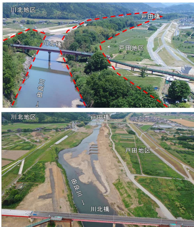
図 1.3.7 由良川の河道内樹木繁茂状況（川北橋付近（41k））
