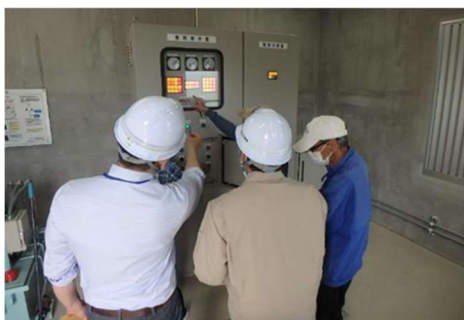
図 5.4.4 樋門機械設備等の点検
