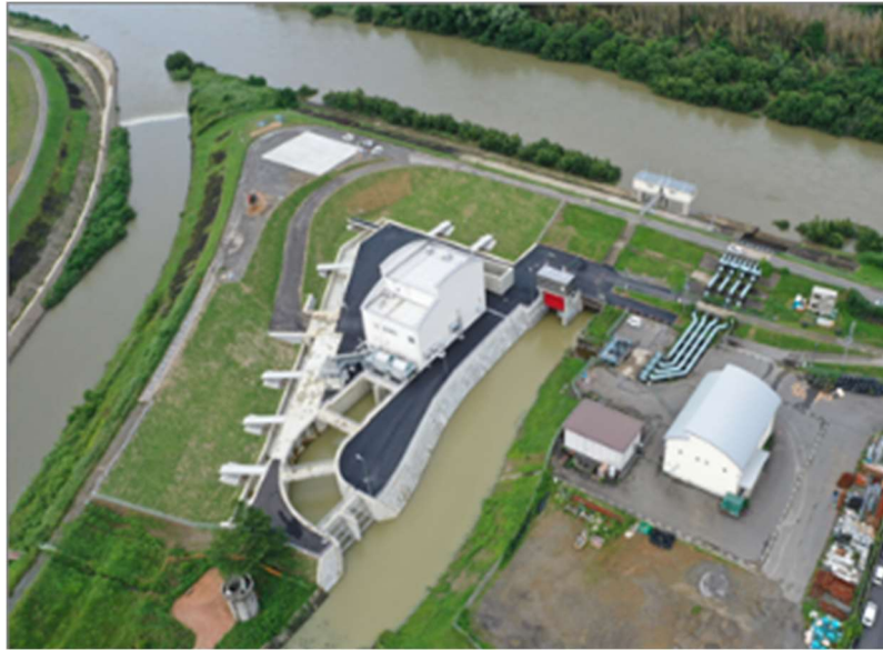
図 6.2.6 弘法川排水機場
