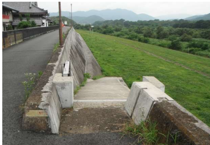
図 6.2.7 福知山第 1 陸閘
