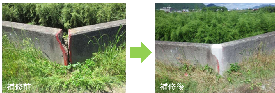
図 6.2.3 特殊堤の補修
