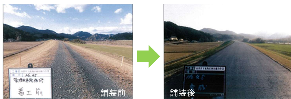
図 6.2.2 堤防天端の舗装
