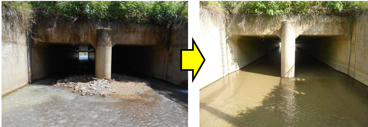
図 6.1.1 維持掘削状況（谷河川樋門）
