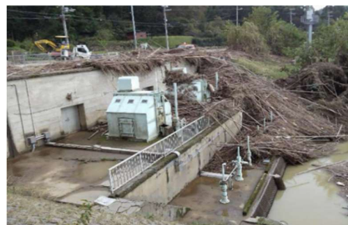
図 5.4.2 出水後の点検（河岸の崩落および流木等の堆積）
