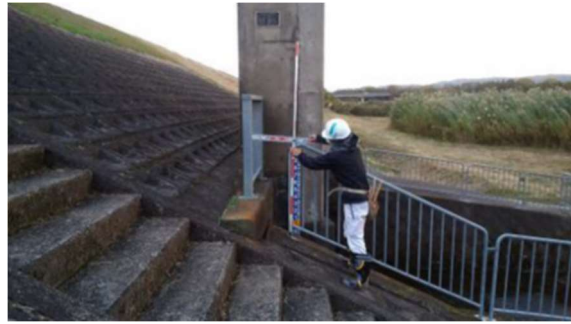
図 5.4.1 河川管理施設（樋門）の点検
