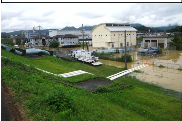
福知山市(弘法川樋門付近:左岸35.2k)
