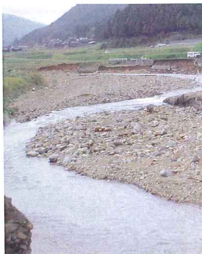
堤防が決壊し田が流され、市道(今井谷線)の道幅の半分が削り取られ通行止めになった(福知山市夜久野町坂生上三谷/牧川)
