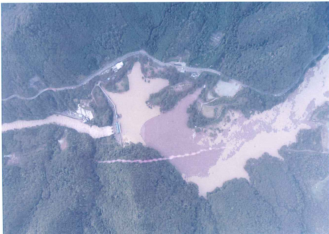
上流から見た流木の状況
