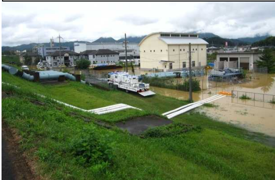
福知山市(弘法川樋門付近:左岸35.2k)
