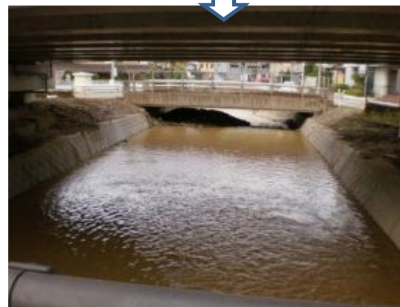
＜和久川支川榎原川＞約80m決壊 河道修復 (8月22日完了)
