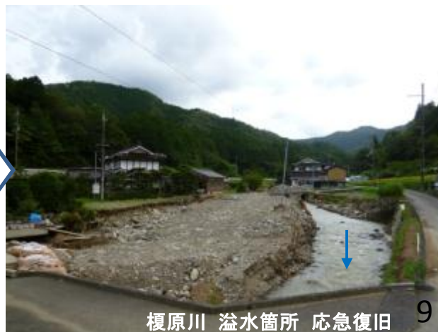
＜和久川支川榎原川＞約80m決壊 河道修復 (8月22日完了)
