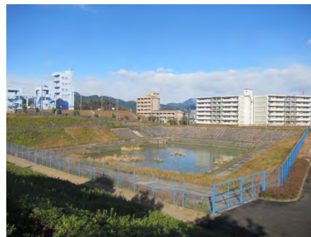
大谷池防災調整池(平成10年度設置)
