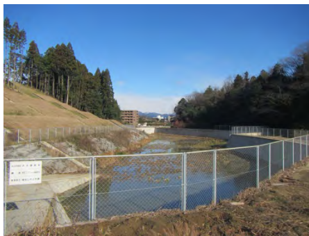
もえぎの丘防災調整池(平成25年度設置)
