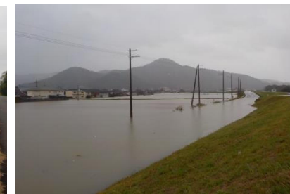
平成29年10月 台風21号 内水氾濫の様子
