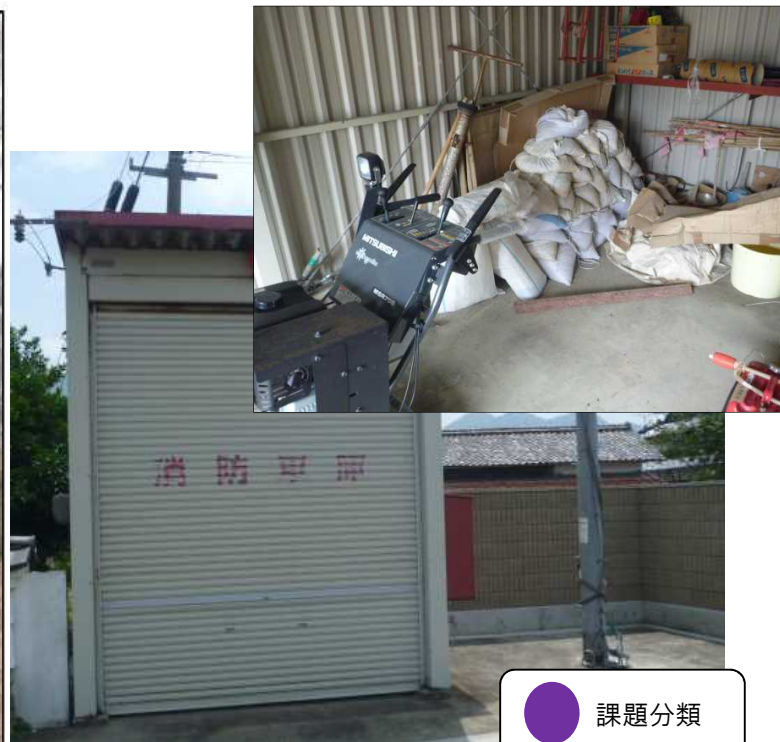
消防車庫を活用した土のうステーション（宮津市）
