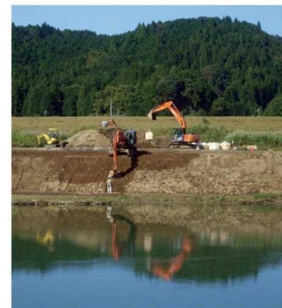
河道掘削イメージ
