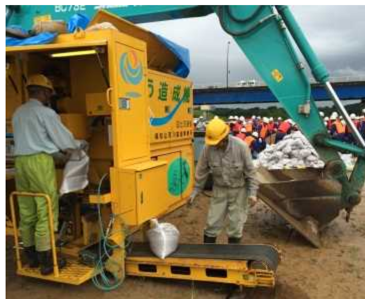
国が保有する土のう造成機による土のうの製造
