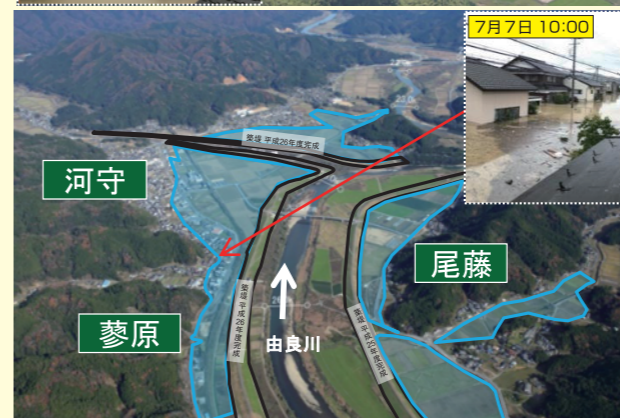
平成 30 年 7 月豪雨による浸水被害 (代表地区)
