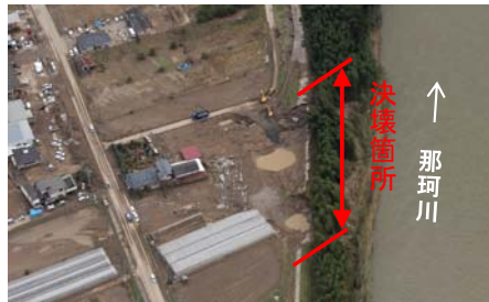
写真③堤防決壊状況（那珂川左岸40.0km）
