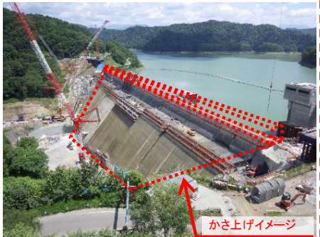
ダム建設・ダム再生
