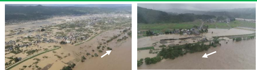
長野市穂保地先の堤防決壊、浸水被害状況 新潟県小千谷市内における浸水被害状況
