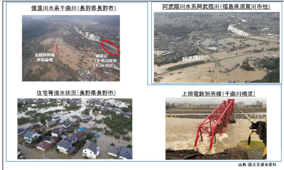
台風19号の被害状況
