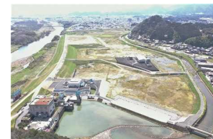
新荒河排水機場、荒河調節池 (京都府)
