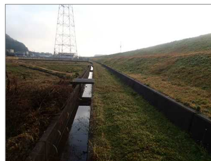
実施前(令和元年12月)
