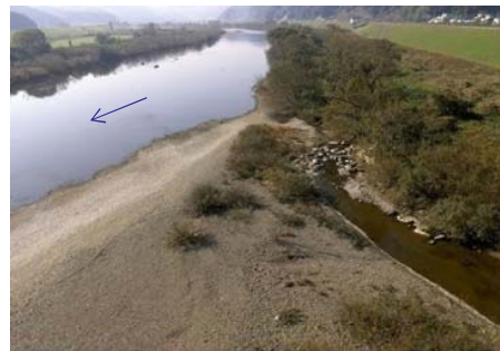
▲土砂堆積・樹木繁茂状況
