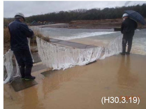
▲オイルフェンスによる対応事例
