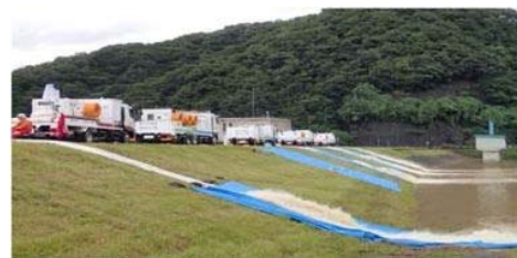
▲排水ポンプ車配置状況(荒河排水機場)
