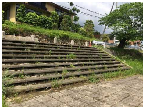
階段②（親水階段護岸）
