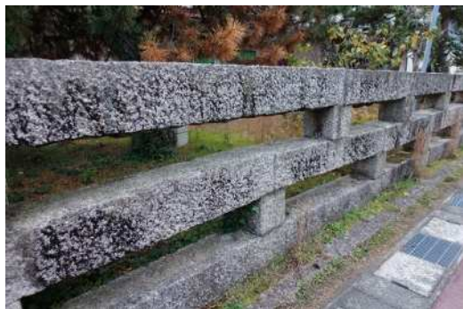
由良石の石堀 [旧由良小学校]
