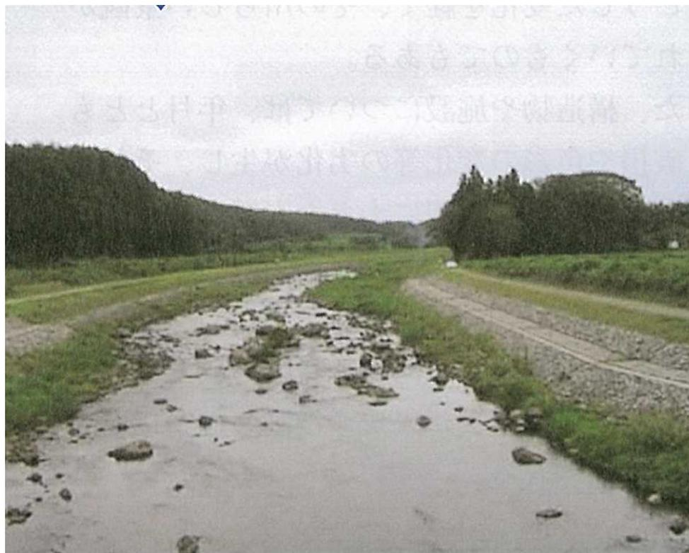
護岸に自然石を用い、河岸に転石を適度に配置することで蛇行を創出し、自然河川を創出した事例
