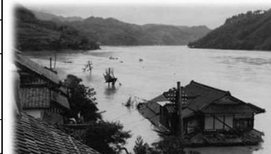
S28 山麓間見渡す限り浸水
