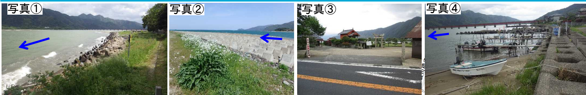
河岸侵食防止として 根固工を整備
