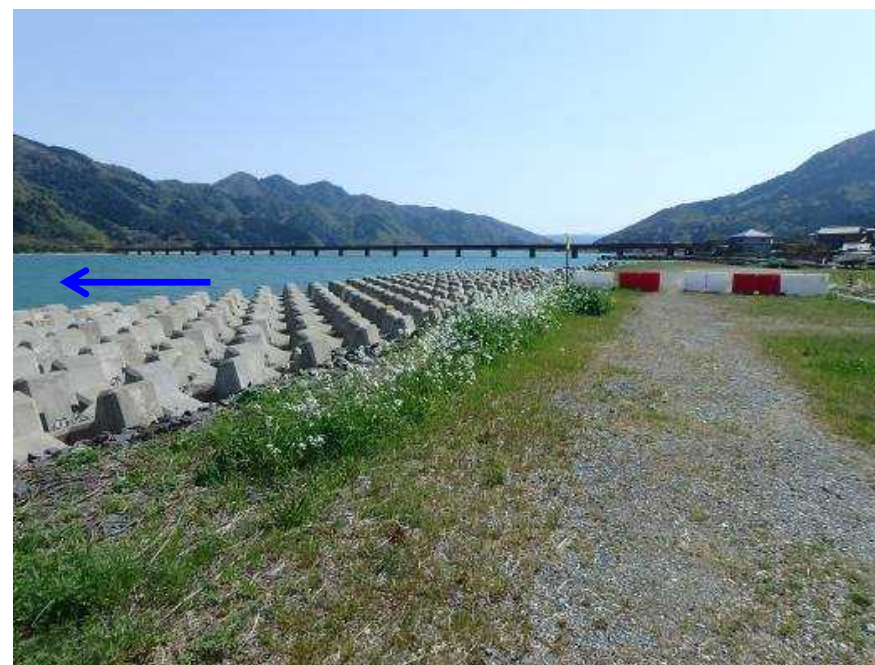
写真 河岸下流側より望む由良川橋梁
