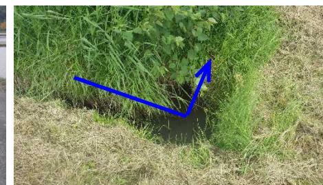
国道178号横断水路
