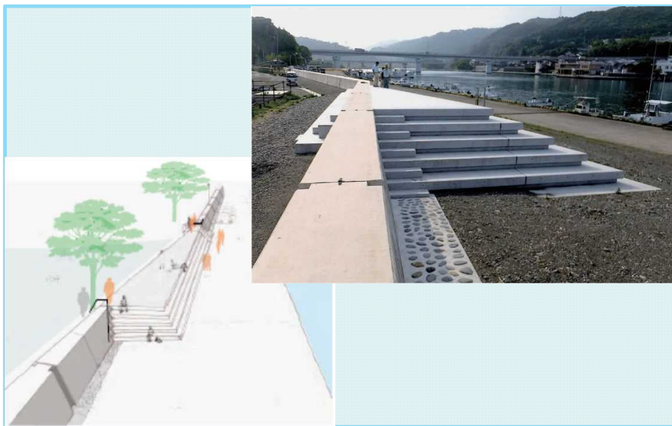
横断機能と防災機能の融合した階段護岸の事例 (例：美々津護岸[日向市美々津町])
