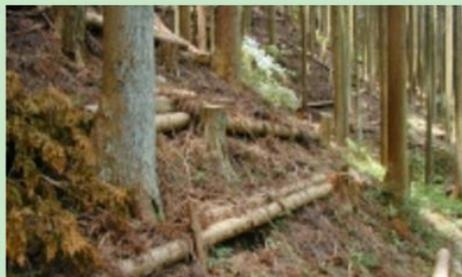
伐倒木を利用した土留工の設置例
