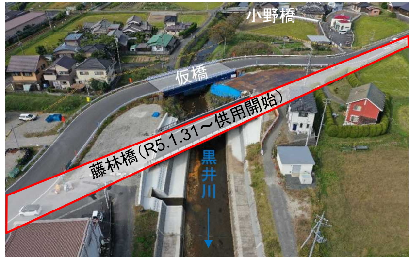
施行中区間(藤林橋)
