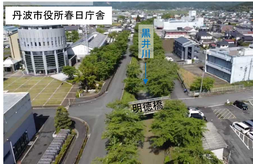
未改修区間(明徳橋)
