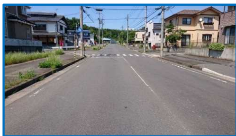
道路排水施設の改良
