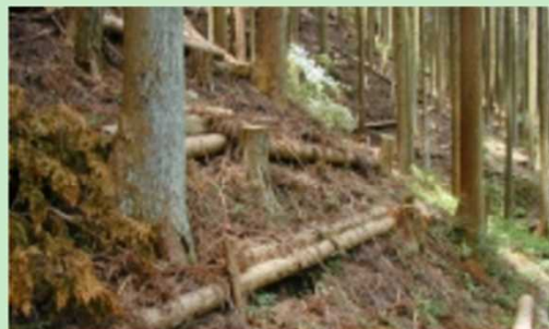
伐倒木を利用した土留工の設置例
