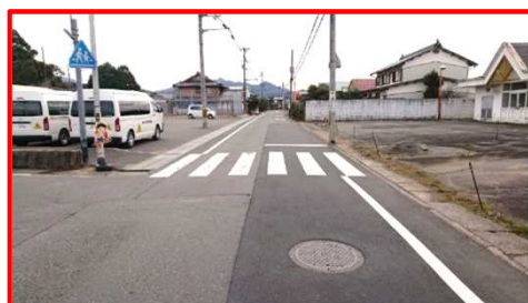
下水道雨水排水路の新設・改良
