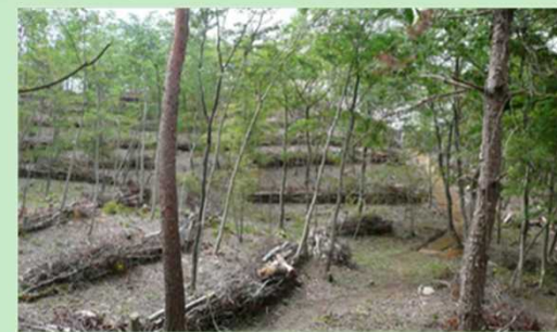
過密林の伐採後に土留工を設置
