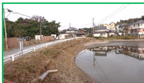
ため池の堤体補強
