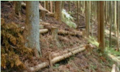
伐倒木を利用した土留工の設置例
