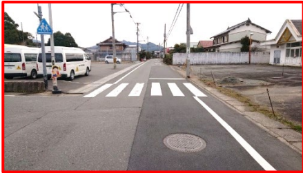
下水道雨水排水路の新設・改良
