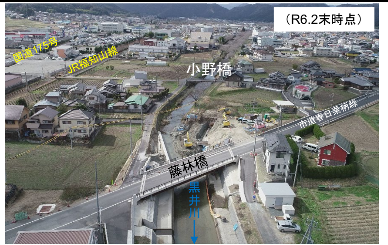
施行中区間(藤林橋)
