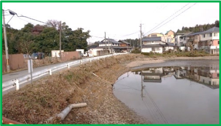
ため池の堤体補強
