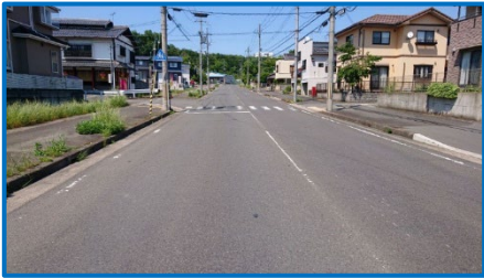
道路排水施設の改良
