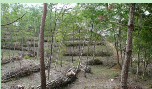
過密林の伐採後に土留工を設置
