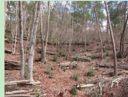
過密化・大径化した広葉樹の伐採後に土留工を設置
