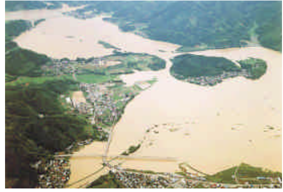
昭和57年 8月（台風10号）大江町河守付近
