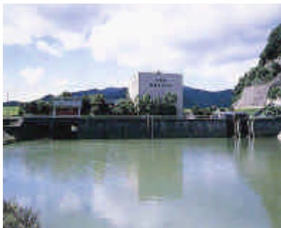
荒河排水機場
