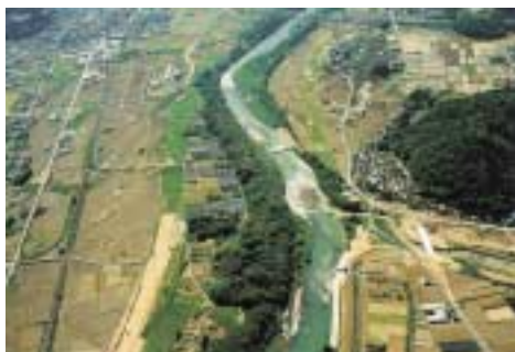
築堤整備状況 綾部市状況
