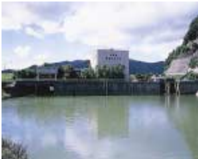
荒河排水機場
