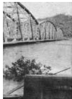
昭和28年9月(台風13号) 大川橋付近(舞鶴市)
