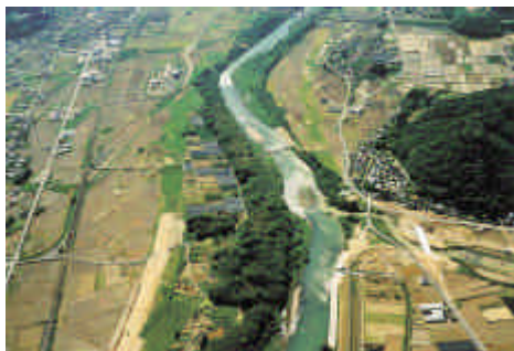
築堤整備状況 綾部市状況
