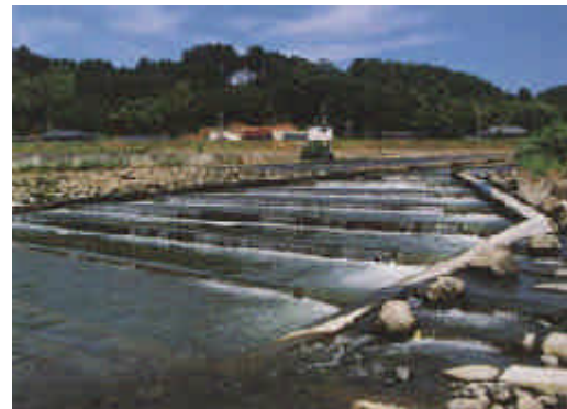
栗村井堰の多段式魚道
