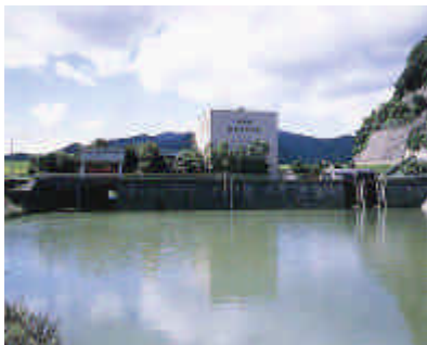
荒河排水機場
