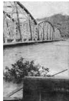
昭和28年9月(台風13号) 大川橋付近(舞鶴市)
