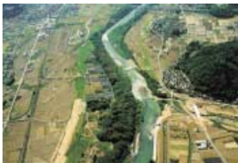
築堤整備状況 綾部市状況
