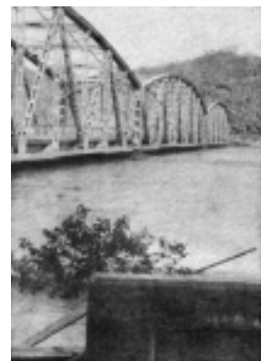
昭和28年9月(台風13号) 大川橋付近(舞鶴市)
