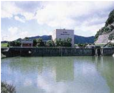
荒河排水機場
