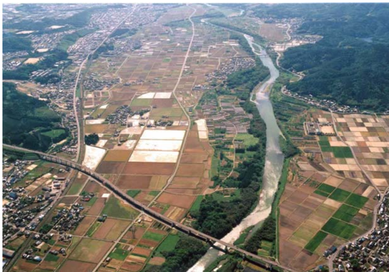
観音寺地区付近 瀬と淵が連続
