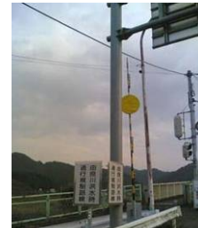
道路遮断機の整備
