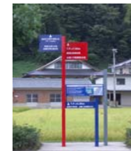
洪水位標の設置
