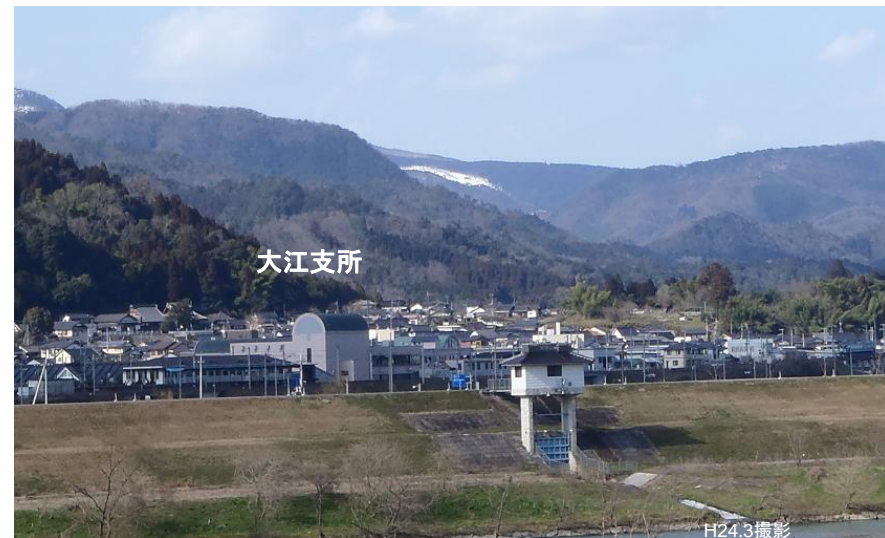
河守地区堤防整備の状況
