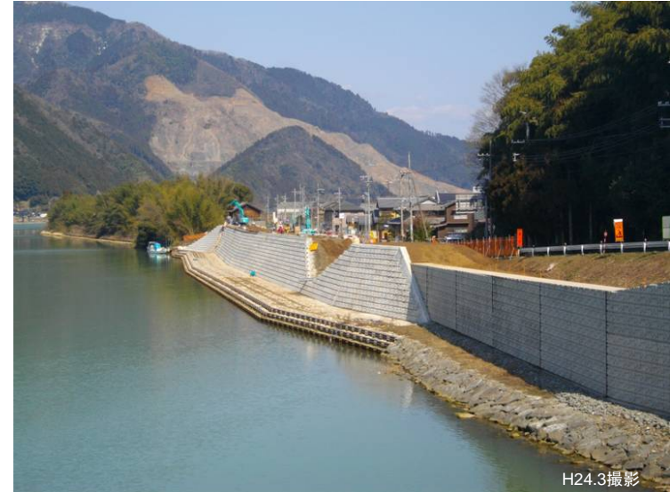
水間・中山地区の築堤護岸整備の状況
