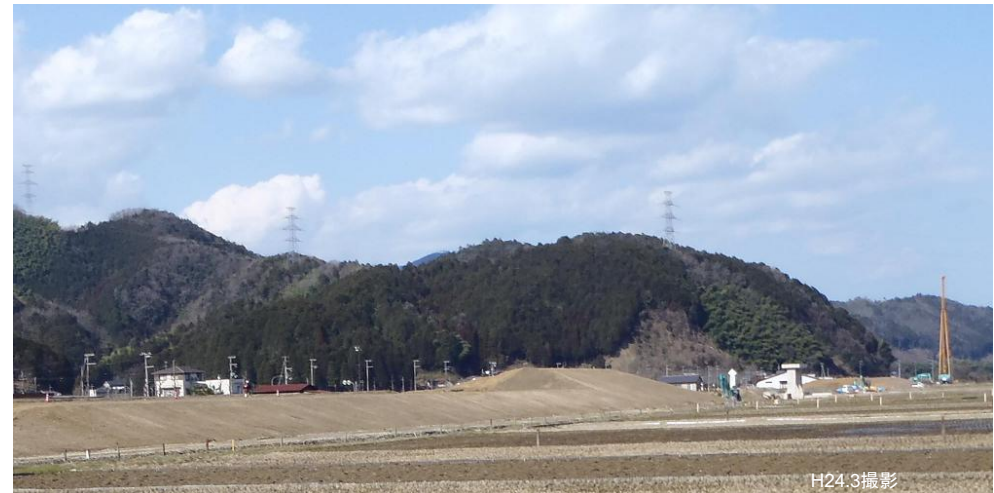
志高地区の築堤状況
