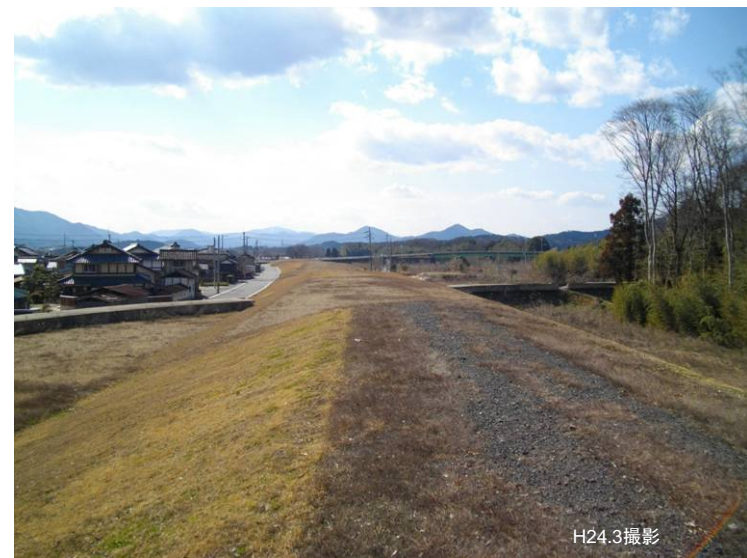
戸田地区の堤防整備状況
