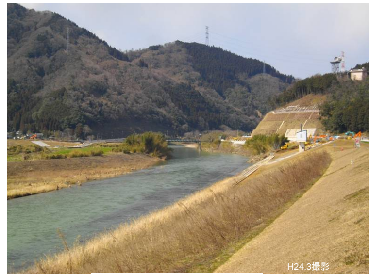
安井地区堤防整備の状況
