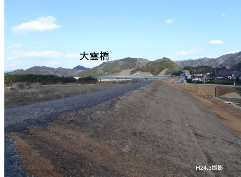
南有路地の築堤状況
