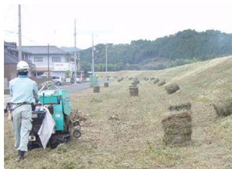
写真 2.4.2 堤防除草作業
