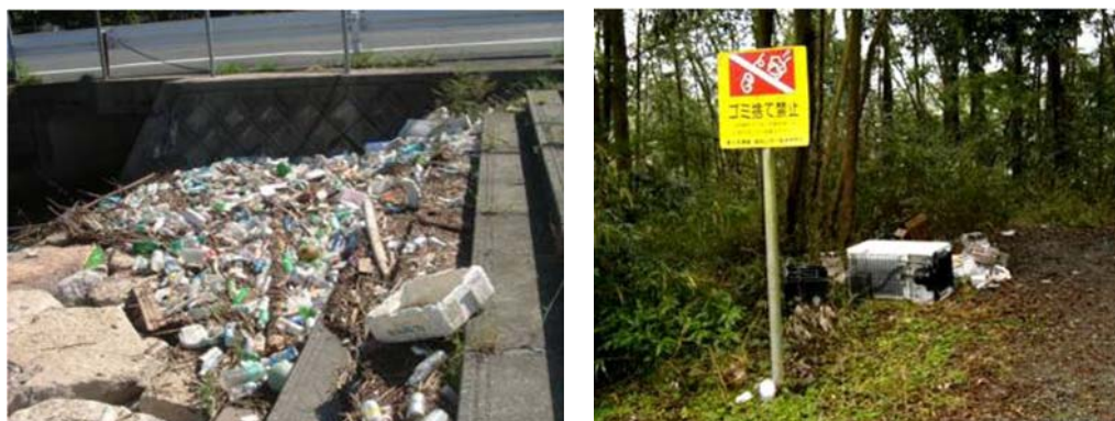
写真 2.4.7 河川区域内のゴミの状況
