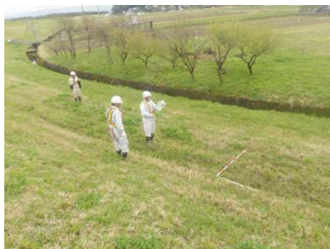
写真 2.4.1 堤防の点検
