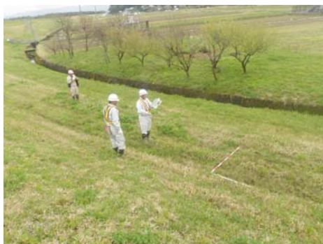
写真 2.4.1 堤防の点検
