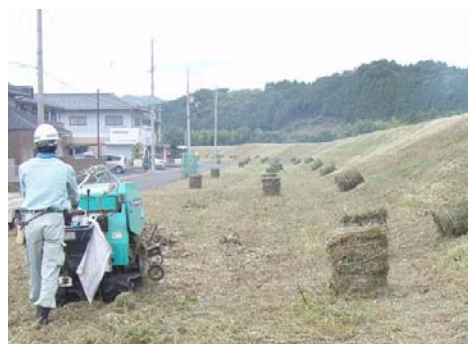
写真 2.4.2 堤防点検のための除草作業
