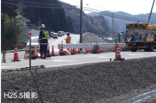
写真① 下流側の乗越道路の状況
